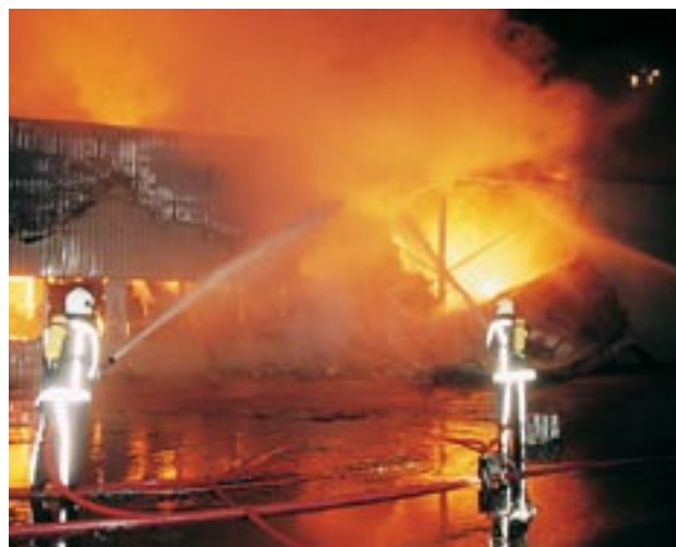
Brand in een opslagruimte, gecompartmenteerd door brandwanden in cellenbeton.
